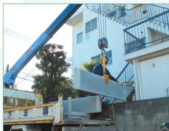
柱が立ち上がれば土圧板を次々入れて、完成
