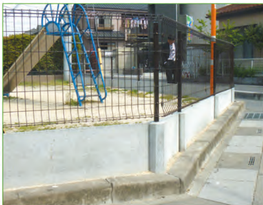
【土の流出防止】や【防草対策】
