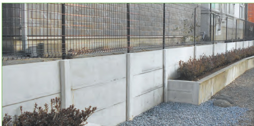
最大高さ１メートルの土留めを構築できます
